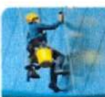
Trabajos en altura
