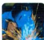
Trabajos en caliente
