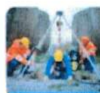
Trabajos en espacios confinados
