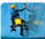
Trabajos en altura
