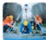
Trabajos en espacios confinados
