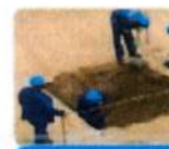
Trabajos de excavaciones superiores a 1.50 m
