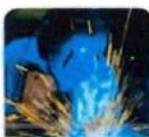
Trabajos en caliente
